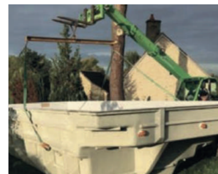
4. Pose en fond de fouille
