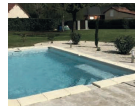
8. Pose des margelles
